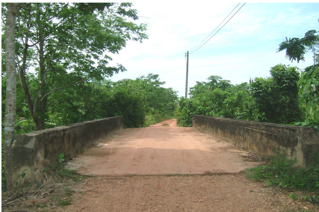
ภาพที่ 24 แสดงสะพานคอนกรีตเสริมเหล็กข้ามคลองवाद ตำบลท่าข้าม อำเภอบางกล่ำ จังหวัดสงขลา
