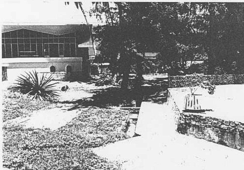
ภาพที่ 2 บริเวณหน้าโรงแรมสมิทธา (ก) ชายหาดหน้าโรงแรม (ข) ทางระบายน้ำตั้งจากโรงแรมที่ปล่อยลงทะเล (จุดที่ 2)
